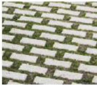
Pavage en béton avec ouvertures de drainage
